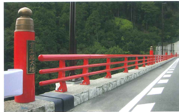
室生路大橋(奈良県)
