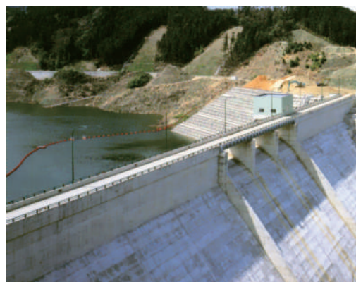
奈良県 天端高欄
